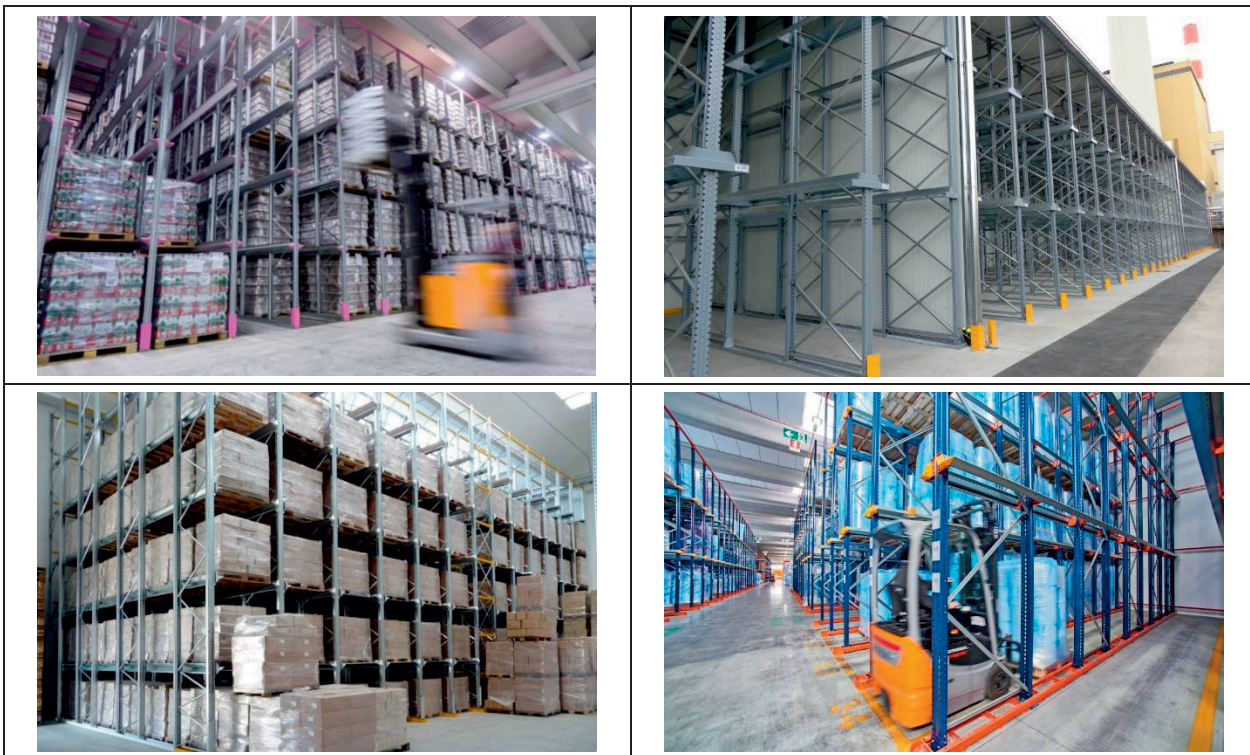
Figura 6.2-2: Scaffalature porta pallet ad accumulo (Drive in, Drive Through) - classificazione 5.1.2 UNI EN 15878
